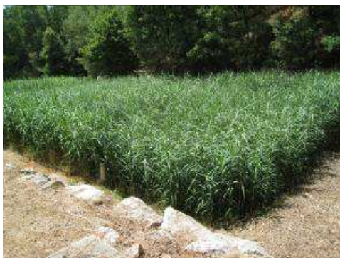
Un procédé innovant : les filtres plantés de roseaux
