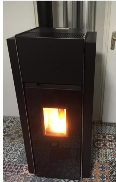
Suppression des radiateurs électriques et utilisation d'une ressource renouvelable
