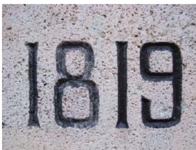
Reprise de lettrage
