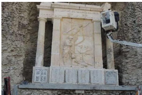
Reprise des joints
