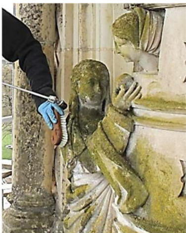
Pulvérisation du biocide et brossage simultané et grattage manuel des lichens
