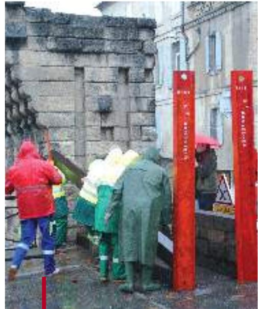
Test de mise en place de batardeaux
